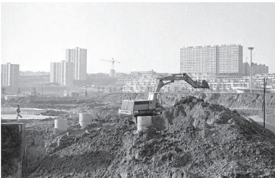
Montagne de terre pour l'arrivée du RER à Val-de-Fontenay, 1975. Archives municipales de Fontenay-sous-Bois.
