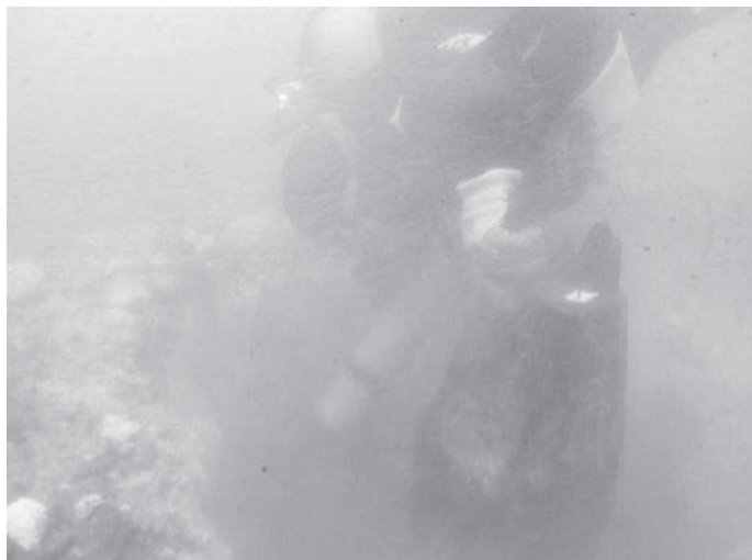
La Seine à Villeneuve-le-Roi - La Surette – Pont 1 dégagement d'un pieu
