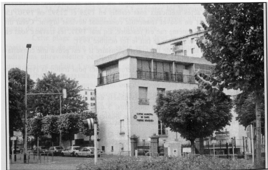
Vitry-sur-Seine - rue Montebello / Général de Gaulle
