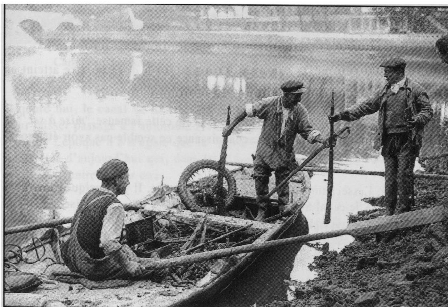
Récupération de fusils, chargeurs, roues,... entre le Pont Sully et le Pont Marie
