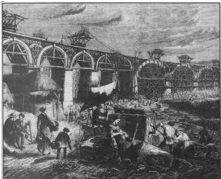
Construction du viaduc de Nogent.
