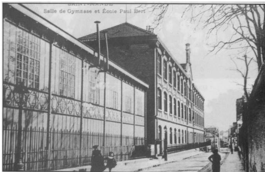
La salle de Gymnase et l'école Paul Bert - Saint-Mandé Edifié en 1889, ce gymnase est un des rares équipements construits dans une école primaire au XIXe siècle Archives Communales de Saint-Mandé
