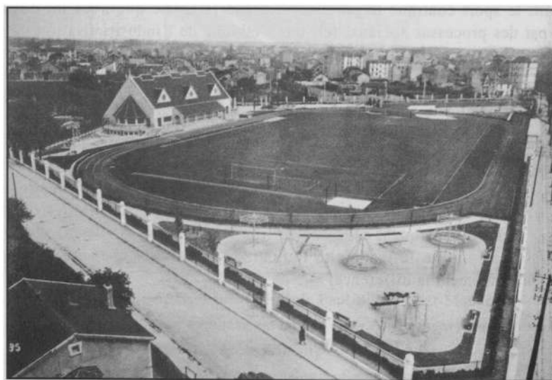
Le stade de la Suze à Maisons-Alfort -La Construction moderne, octobre 1935
